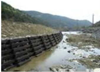
Construcción con bloques de polietileno (PE)
