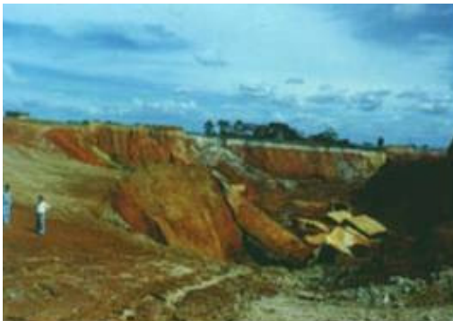
Daños causado por erosión
