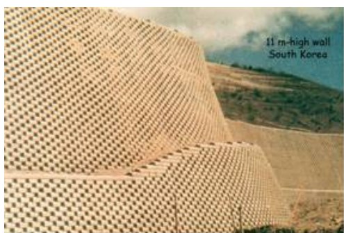
Muro elaborado con mampostería modular
