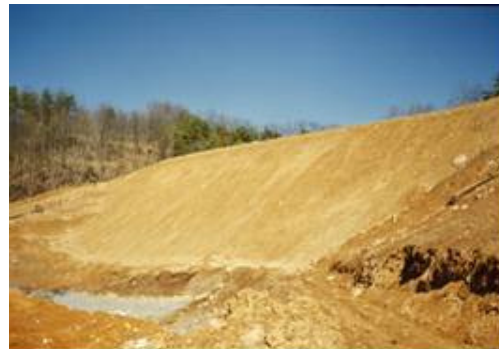
Terraplén reforzado terminado
