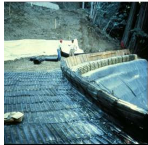
Ejemplo de talud restaurado con suelo reforzado.
