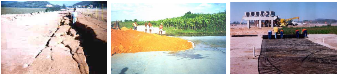
Falla típicas de terraplén no reforzado y usos de geosintéticos como refuerzo
